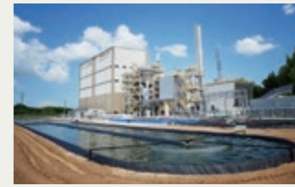
培養プールはコンクリートによる造成ではなく、外周をあぜで塗り固めることでコストを削減できた。
