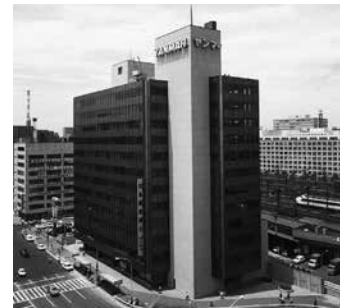
ヤンマー興銀合同ビル(東京支店)1972年
