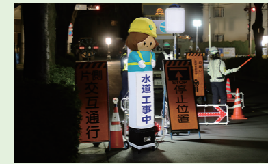
夜間の工事現場
